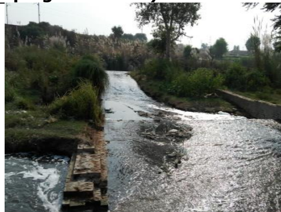
Fig- Confluence point of ICI Drain & River Pandu
