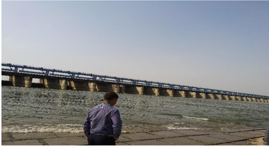
Figure 9 Kanpur (Luv Kush) barrage
